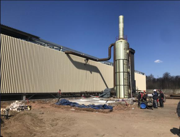
Назначением проектируемого объекта является переработка отработанных пластика/шин, получение жидких топливных фракций пиролиза (далее – пироконденсат), получение газовой фракции (далее – пирогаз) и твердого сажевого (углеродного) остатка.
